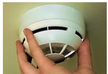
год требуется менять батарейки. И периодически, как минимум раз в полгода, снимать и продувать камеру с оптикоэлектронным датчиком пылесосом, чтобы избежать ложных срабатываний от осевшей пыли. Стоит дымовой извеща-
